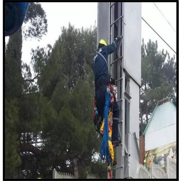
Рис. 4. Подъем по опоре
