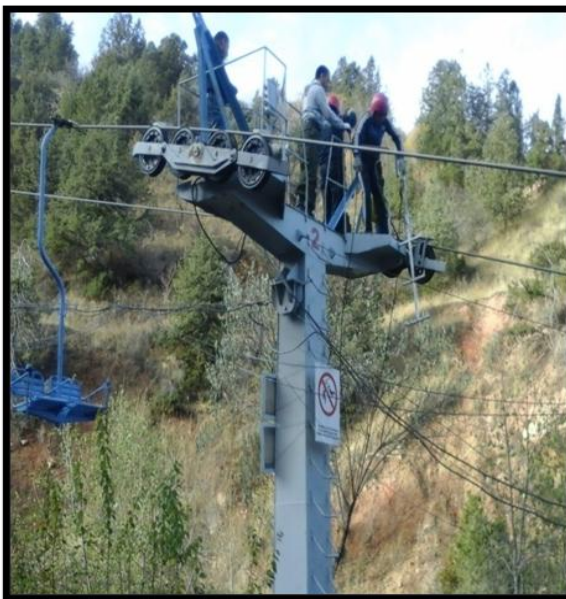
Рис. 5. Установка навесной стремянки на несущий канат.
